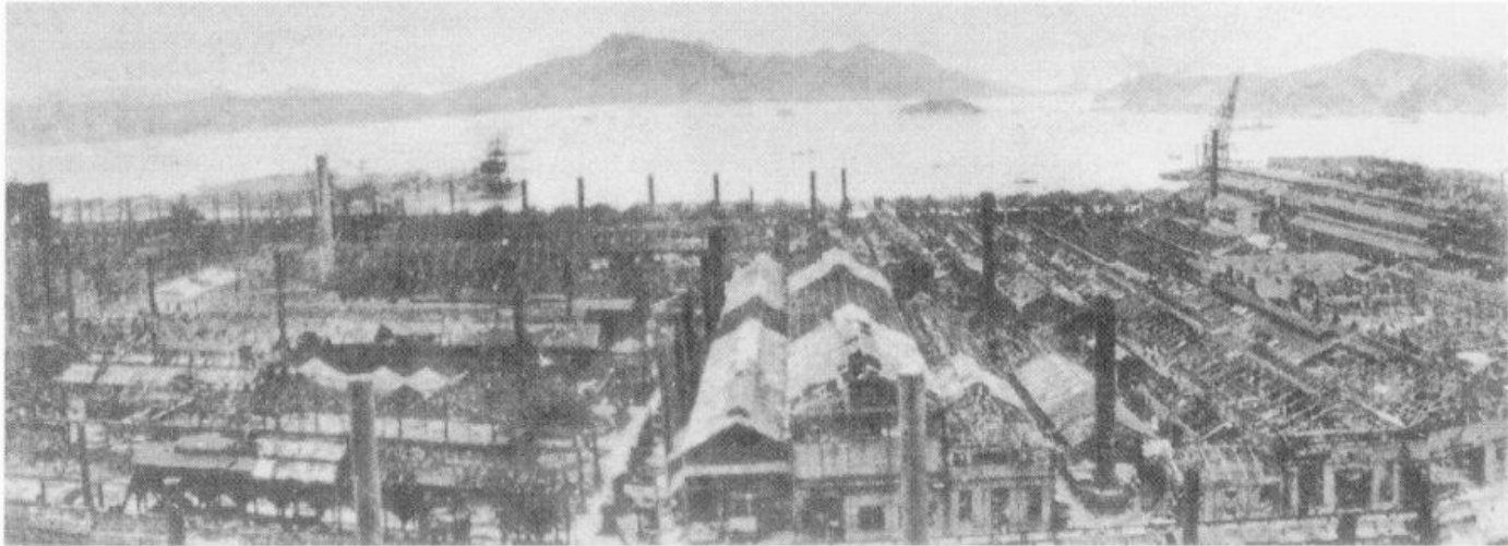
廃墟となった呉海軍工廠。鉄骨と一部の建物だけ残った。右端に見える200トンクレーンは現在もある。
