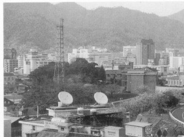
IDDNパラボラアンテナ（呉総監部内）
