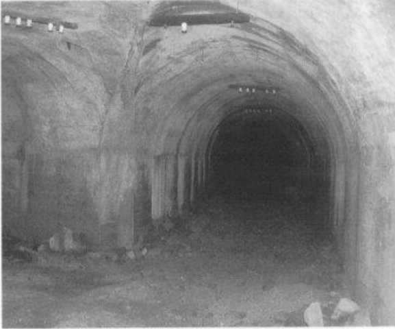
今も残る地下工場の跡
